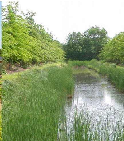
Bassin végétalisé de récupération des eaux pluviales, ZA des Ajeux FertéBernard (72) Concepteur HYL © S. Larramendy
